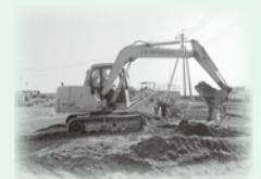
バックホー(0.25m³)による掘削作業
