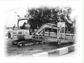
小型バックホーの掘削作業
