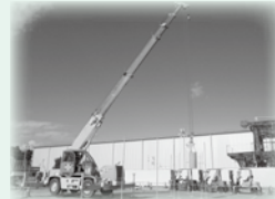
教習風景 (ラフテレーンクレーン(つり上げ荷重10t))
