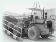
掘削作業中のトラクターショベル(タイヤ式)
